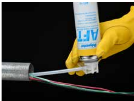
Steel conduit installation
